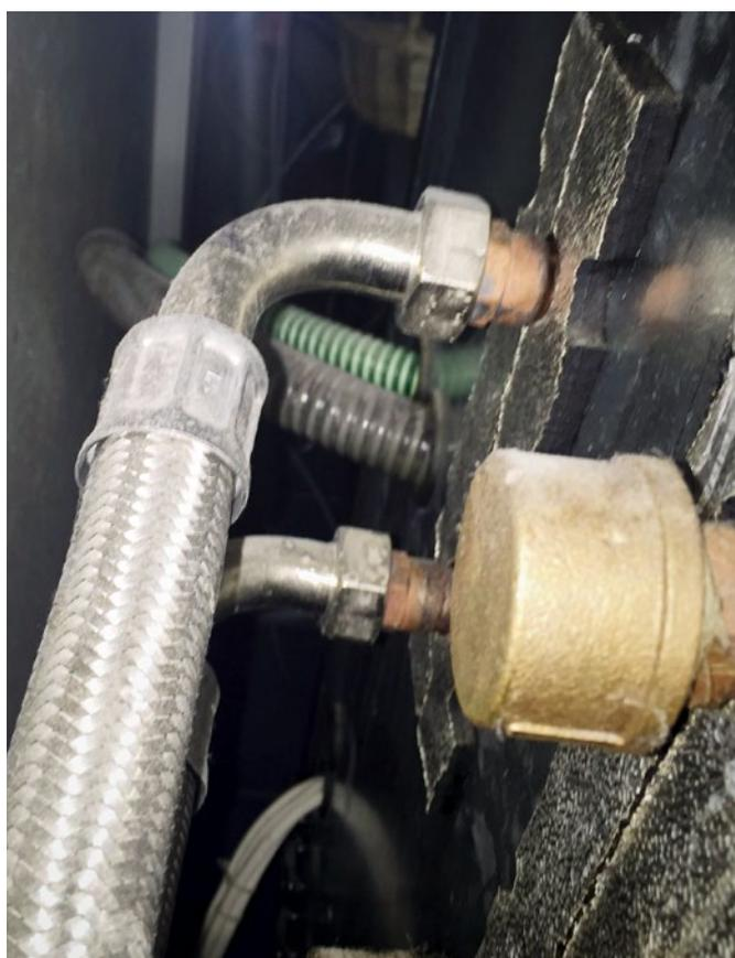
**[FIG. 11]** Pompe à chaleur avec raccords EPDM non étanches à l'oxygène.
