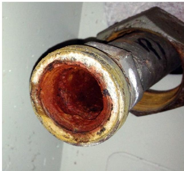
[FIG. 2] Distributeur de chauffage au sol: résidus de corrosion.
